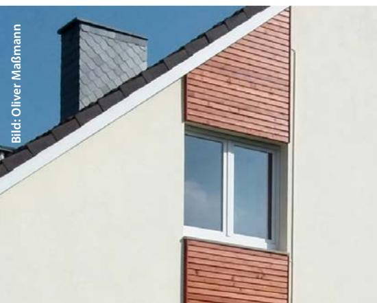
Fassadenverkleidung, Rhombus-Profil Thermo-Kiefer
